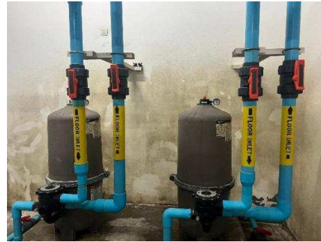
รูปที่ 3-48 ระบบกรองน้ำสระว่ายน้ำ
