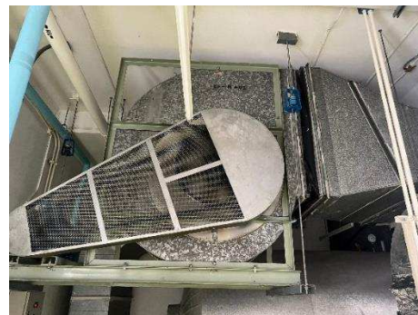
รูปที่ 3-62 พัดลมระบายอากาศ
