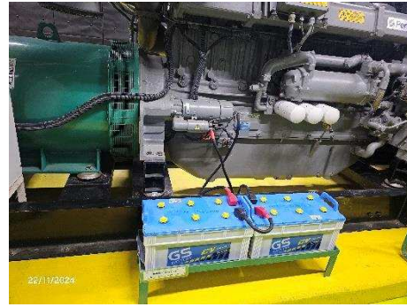
รูปที่ 3-56 แบตเตอรี่สำรอง
